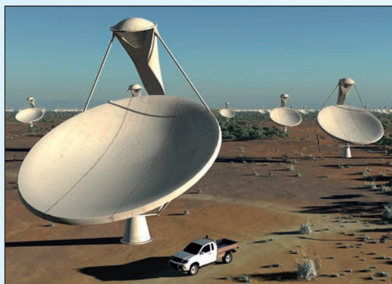
Система параболических рефлекторов 15-метрового диаметра (иллюстрация).
