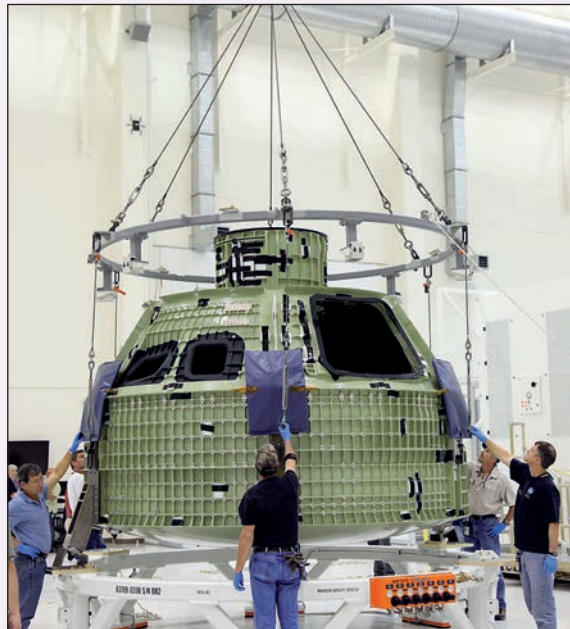
Корпус нового корабля Orion монтируют на пьедестале в Космическом центре имени Кеннеди на мысе Канаверал (штат Флорида).
